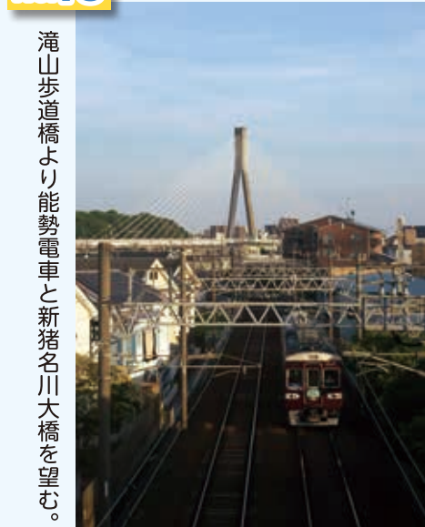
滝山歩道橋より能勢電車と新猪名川大橋を望む。
